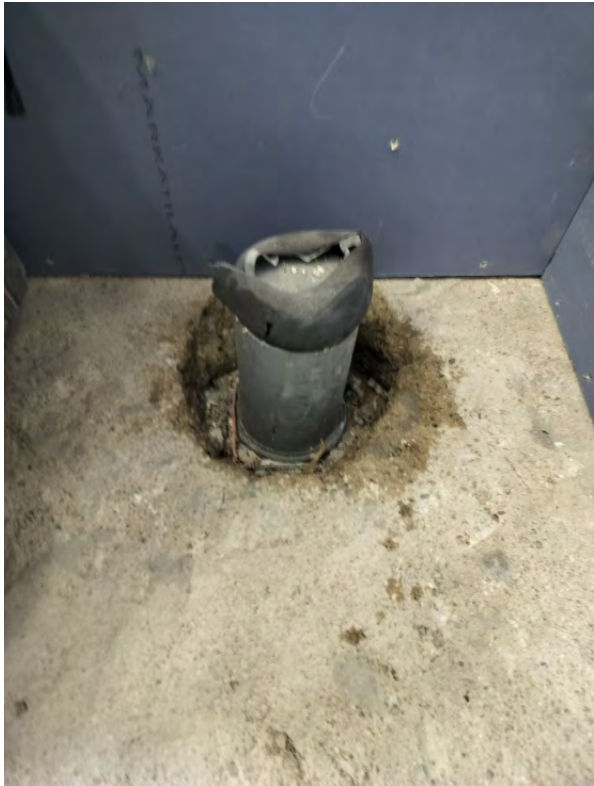
23 - kph. Wc-pytyn viemäriputki korotettu suunnitelman mukaisesti - Petteri Hujanen - 15.04.2026
