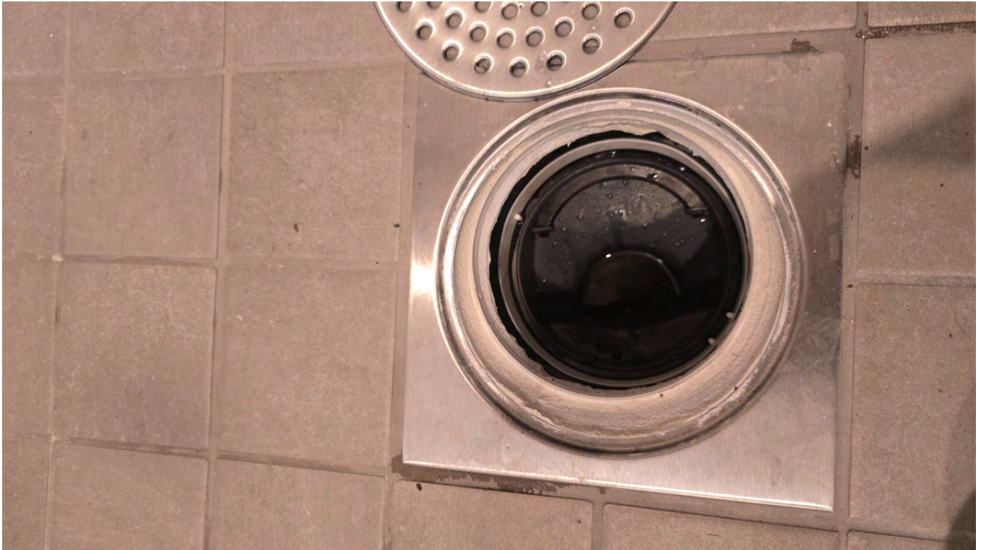
4 - Valmis lattiakaivo ja kaivonkansi. Lattiapinnan kaadot ohjautuvat kaivolle. - Petteri Hujanen - 19.05.2026
