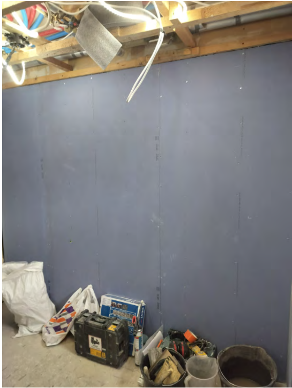
21 - Kph. Makuhuoneenvastainenseinä levytetty märkätilalevyllä suunnitelman mukaisesti - Petteri Hujanen - 15.04.2026
