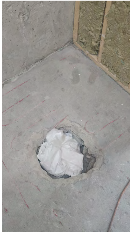
16 - Pesuhuoneen märkäkaivo poistettu. Kaivon uusinta valmisteltu seuraavaa työvaihetta varten. - Petteri Hujanen - 11.04.2026
