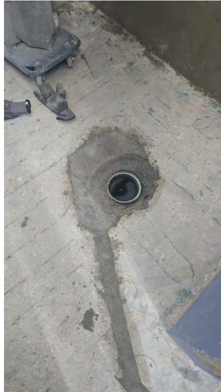
18 - Kuva 5: Lattiakaivon asennus ja valu - Petteri Hujanen - 16.04.2026
