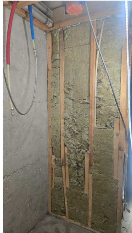
15 - Saunanvastainen seinä purun jälkeen. Runkorakenne ja tekniset asennukset tarkastettu ennen jatkotöitä. - Petteri Hujanen - 11.04.2026
