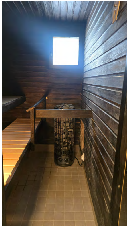
3 - Valmis sauna. Saunan lattia uusittu ja kiuas asennettu käyttövalmiiksi. - Petteri Hujanen - 19.05.2026
