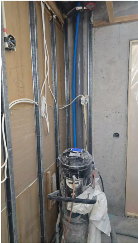
14 - Keittiönvastainen seinä purun jälkeen. Seinärakenteessa havaittu 40 mm peltiranka, joka vaikutti räätipatterin uppoasennuksen toteutukseen. - Petteri Hujanen - 11.04.2026
