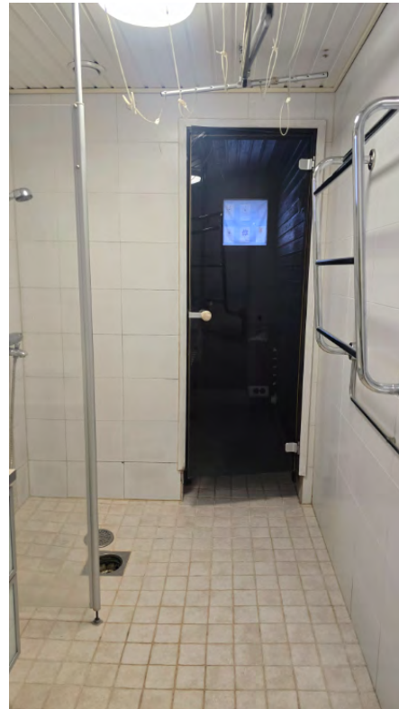
9 - Pesuhuoneen lähtötilanne sisäänkäynnin suunnasta. Remontti käynnistettiin suojausten jälkeen. - Petteri Hujanen - 07.04.2026
