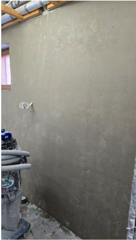
19 - Tasoitettu seinäpinta ennen vedeneristystä. Seinät valmistettu vedeneristysjärjestelmän mukaiselle alustalle. - Petteri Hujanen - 16.04.2026
