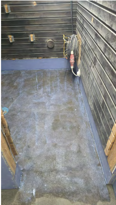
25 - Saunan lattian tasoitus ja kaadot tarkastettu. Lattia valmisteltu vedeneristystä varten. - Petteri Hujanen - 17.04.2026
