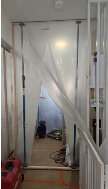
12 - Kulkureitti ja työalue suojattu purkutöiden ajaksi. - Petteri Hujanen - 11.04.2026
