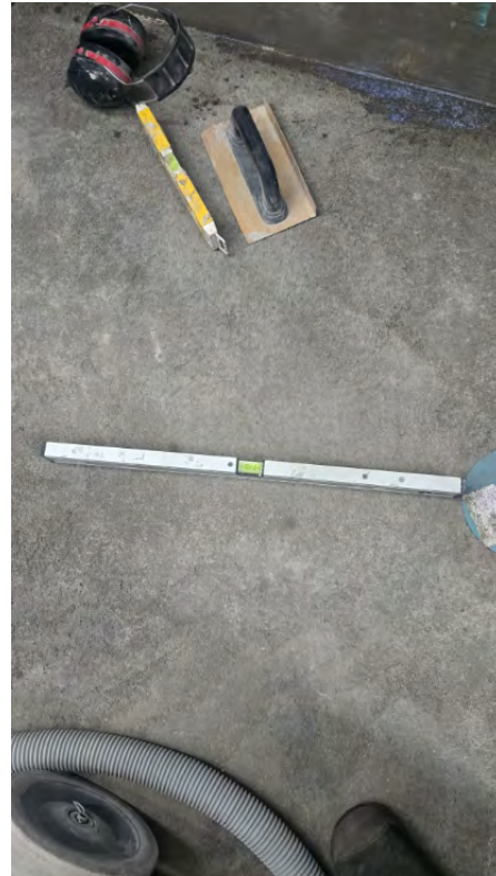
26 - Lattiakaatojen tarkastus vesivaa'alla. Kaadot ohjautuvat lattiakaivoille suunnitellusti. - Petteri Hujanen - 17.04.2026
