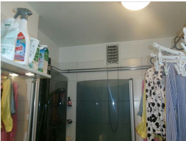
Kuva 9. Kylpyhuoneen poistoilmaventtiili
