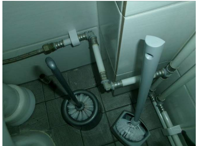
Kuva 42. Vesijohdot pintaan asennettua komposiittiputkea
