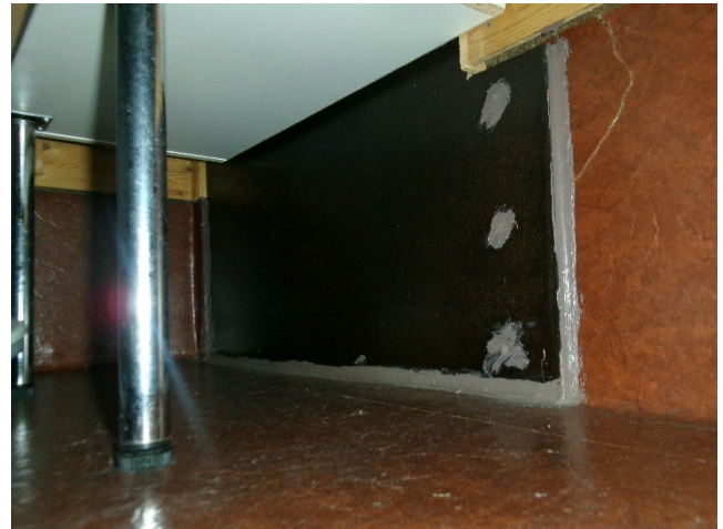
Kuva 18. Vanha keittiöön avautunut ovi ummistettu, kohdalla seinön alaosa tiivistetty vesivanerilla ja liimatiivistemassalla / silikonilla
