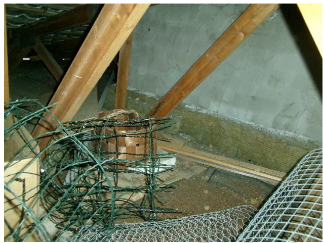
Kuva 16. Savuhormin vierellä asianmukaisesti pystyyn asennettu palovillaeriste
