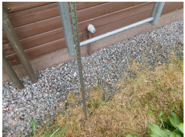
Kuva 14. Talotikkaiden alin puola sijaitti suosituksia lähempänä vierusmaapintaa
