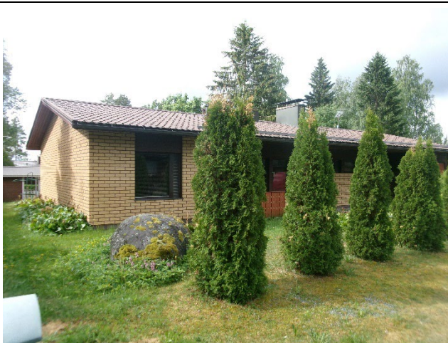
Kuva 5: Yleiskuva julkisivusta (etupiha)
