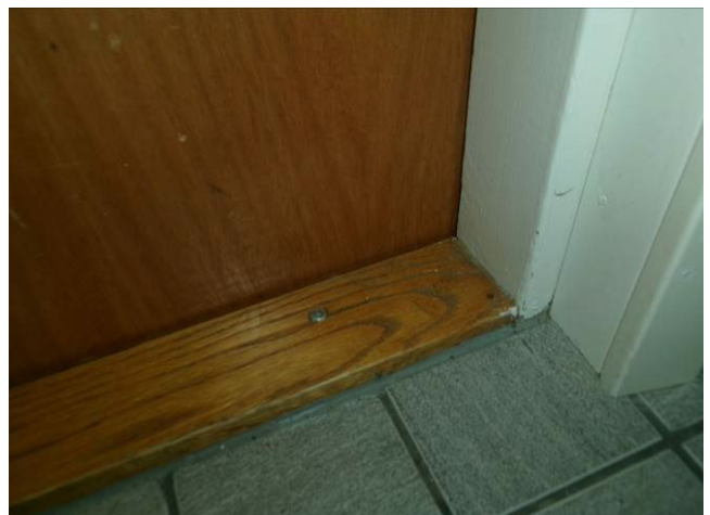
Kuva 26. Oven ja kynnyksen välissä ei tuuletusrakoa
