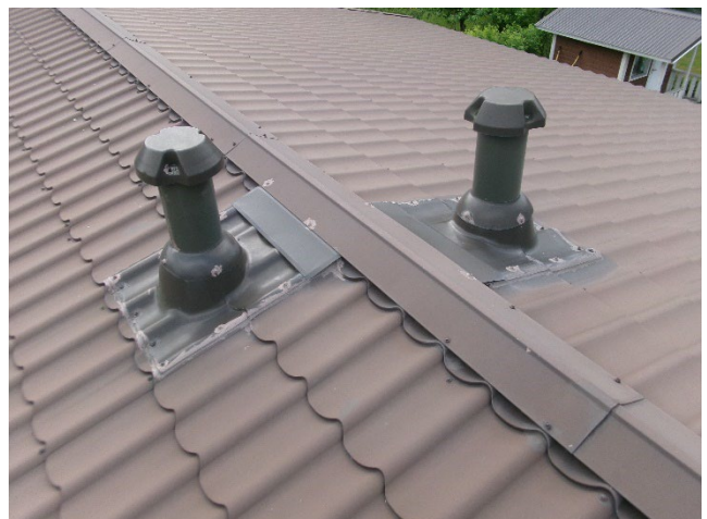
Kuva 12. Läpivientien pellityksiä tiivistetty massamalla
