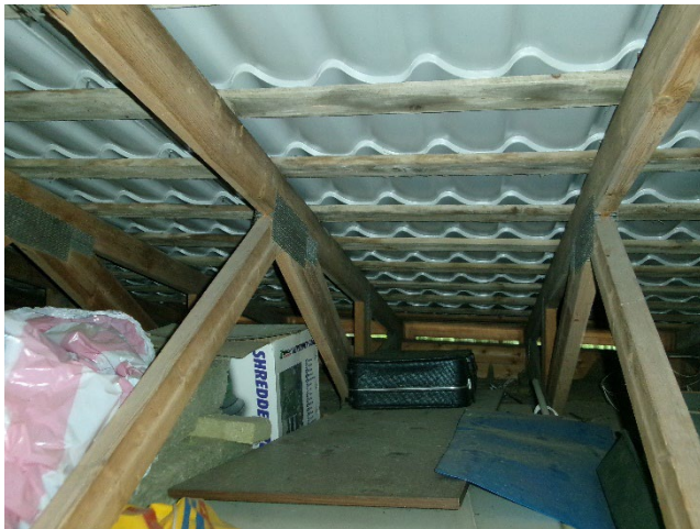
Kuva 15. Yleiskuva yläpohjasta. Tilassa säilytyksessä tavaraa, vesikatteen alla ei aluskatetta, tuuletusrako havaittavissa räystäällä (valo paistaa tilaan)
