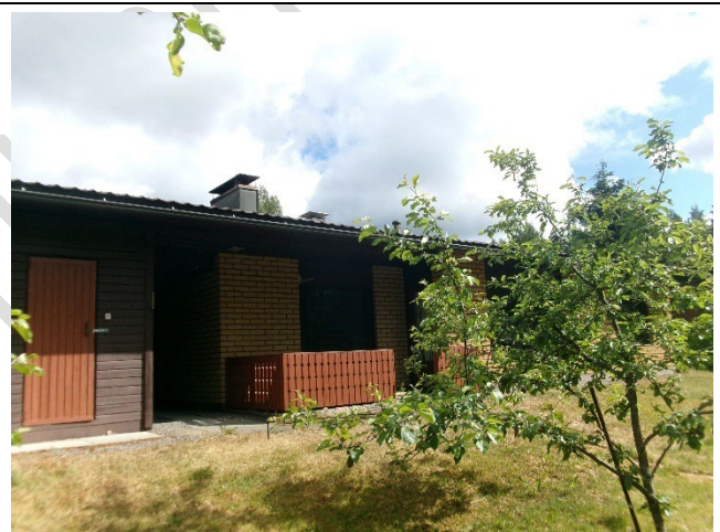
Kuva 6: Yleiskuva julkisivusta (takapiha)
