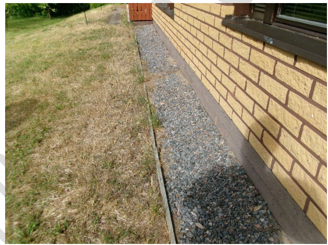
Kuva 2: Vierustalla sepelikaista, maanpinnan kaato pois päin rakennuksesta
