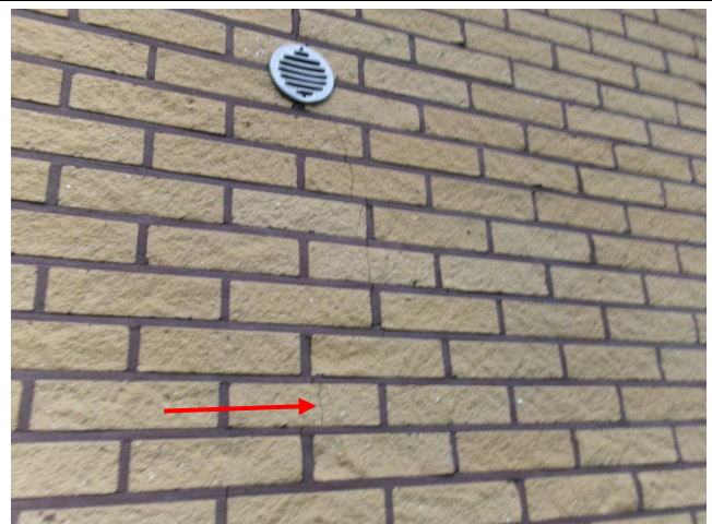
Kuva 8: Halkeama ulkoverhousstiilissä
