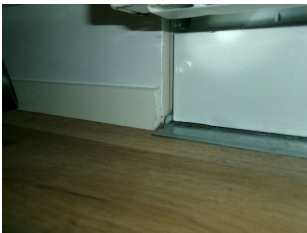
Kuva 29. Pesukoneen alla valumakaukalo (peltiä)
