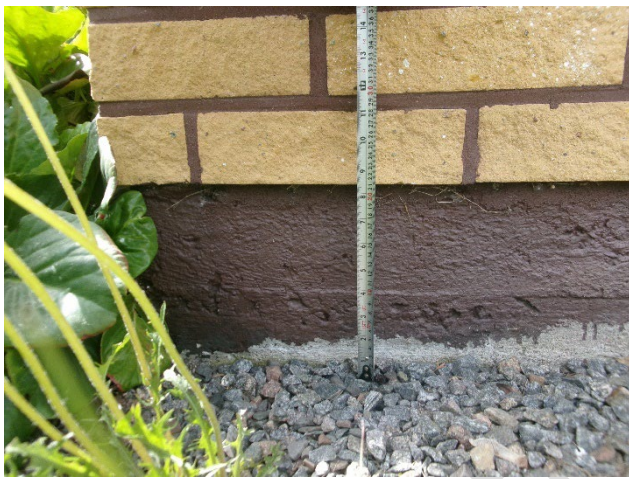
Kuva 1: Sokkelin korkeus keskimäärin 20 cm
